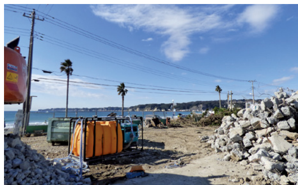
▲旧町営住宅岩和田団地を解体しています。
