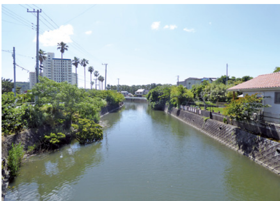
▲町内の12か所で水質検査が行われています。 (写真：清水川)
