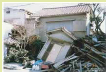
倒壊した被災家屋 (平成7年阪神・淡路大震災)
