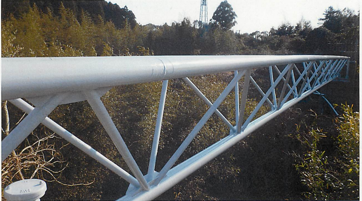
国郷橋水管橋
