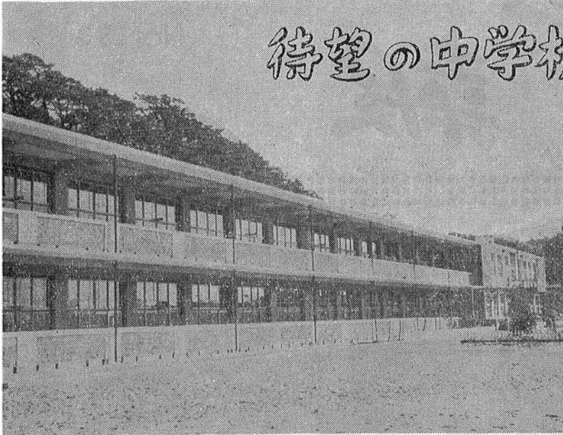
完成した中学校々舎
