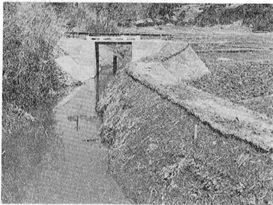
完成した、清水川用水路（せき止め、橋梁）ことしも引きつづいて排水路、落差堰などの工事が行なわれます。
