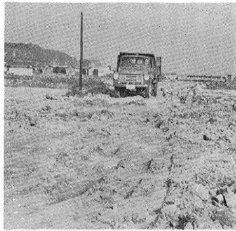
駐車場として整備が進む須賀理め立て地
