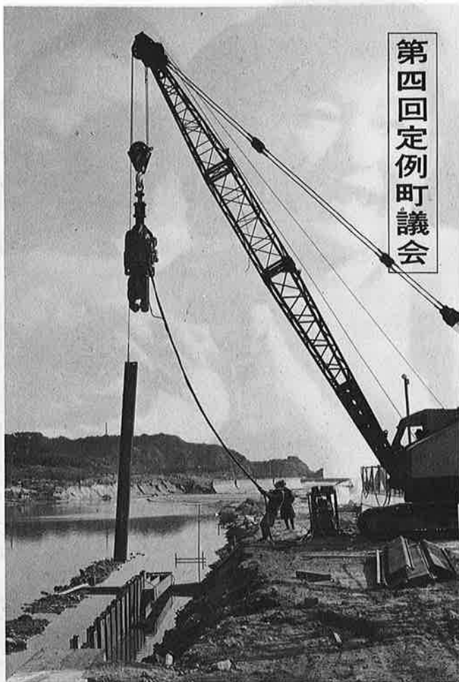
災害復旧の清水川護岸工事は急ピッチ
