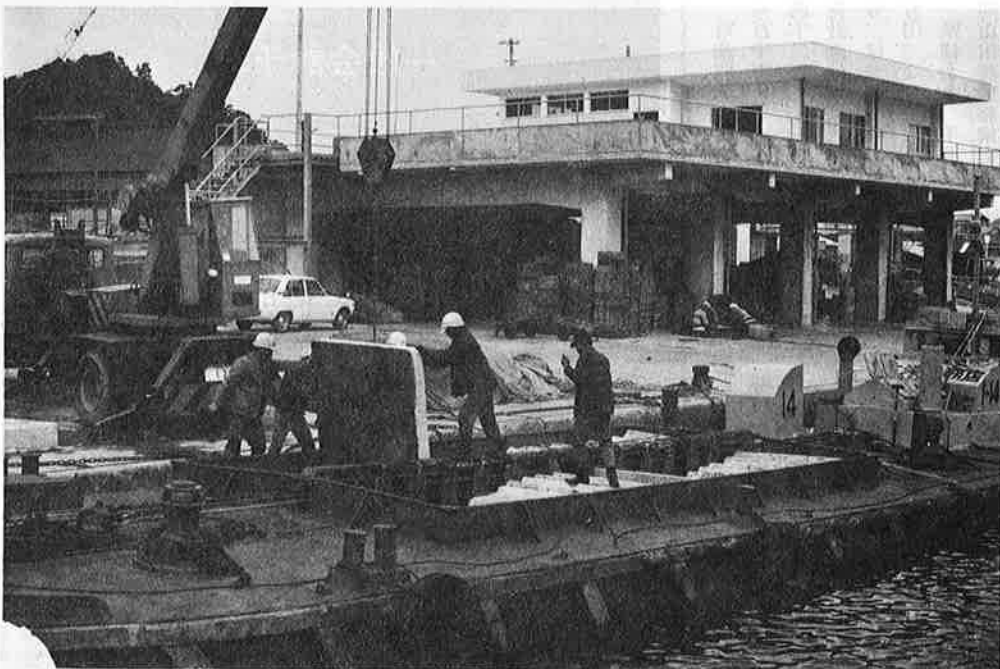
写真＝獲る漁業からつくる漁業への転換・コンクリート投石作業
