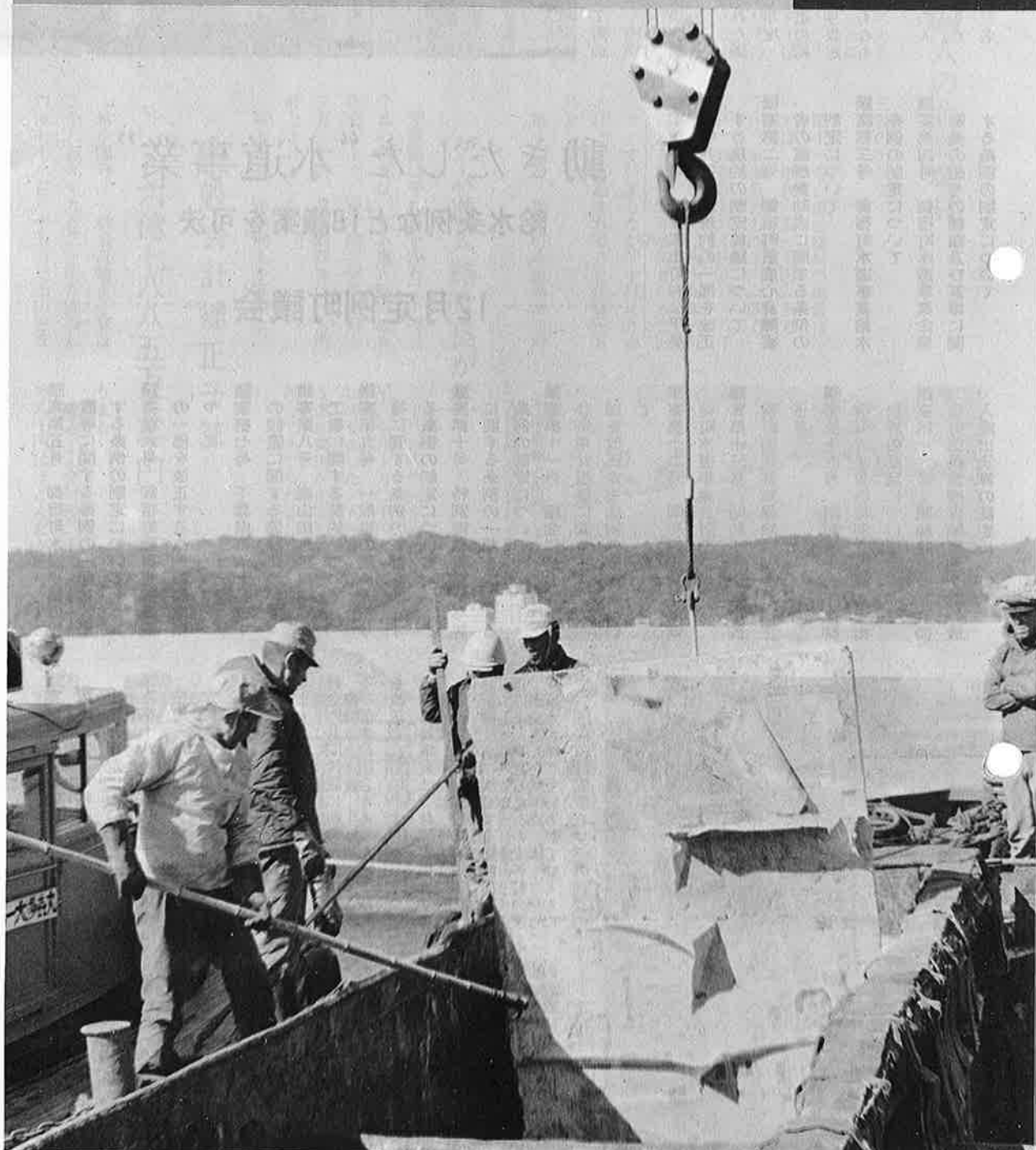
つづ 載る漁業への期待を担って さかなのアパート(漁礁)を海底へ投下する作業
