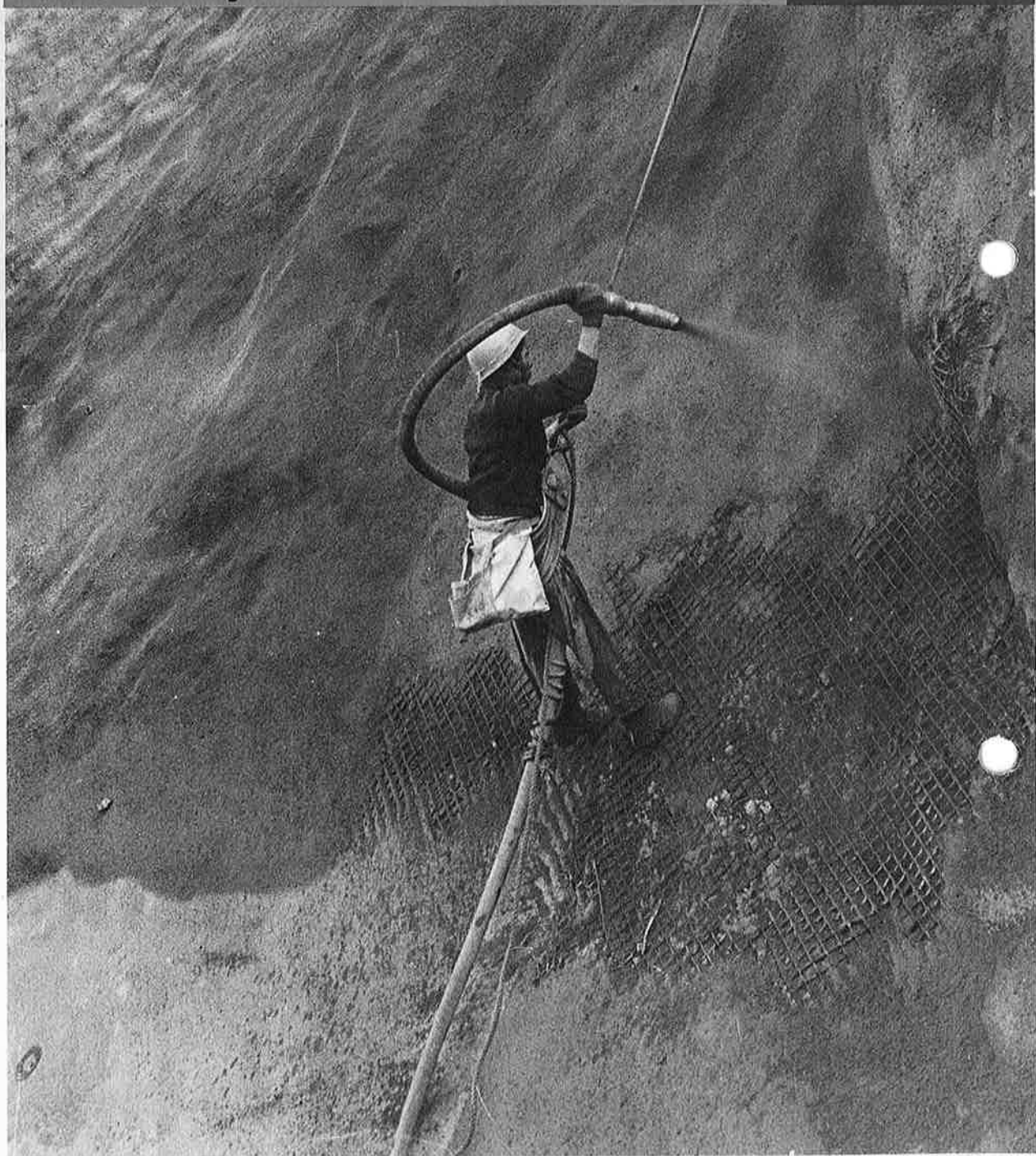
ガケ崩れの危険のある急傾斜地をコンクリートでふき付ける作業
