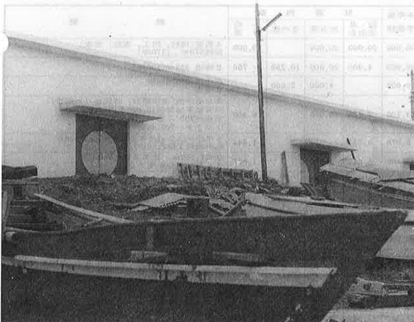
漁家経営に威力を発揮する漁具倉庫の完成
