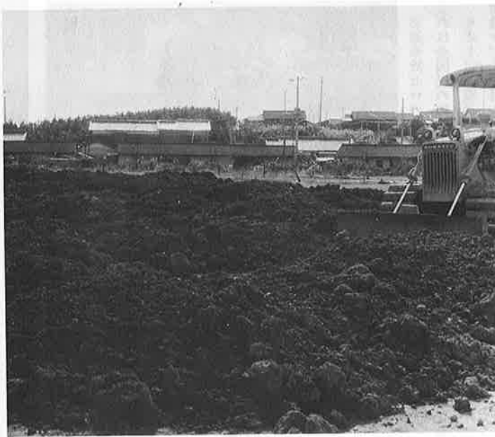
広い駐車場に土を入れ、野球の練習場をつくります
