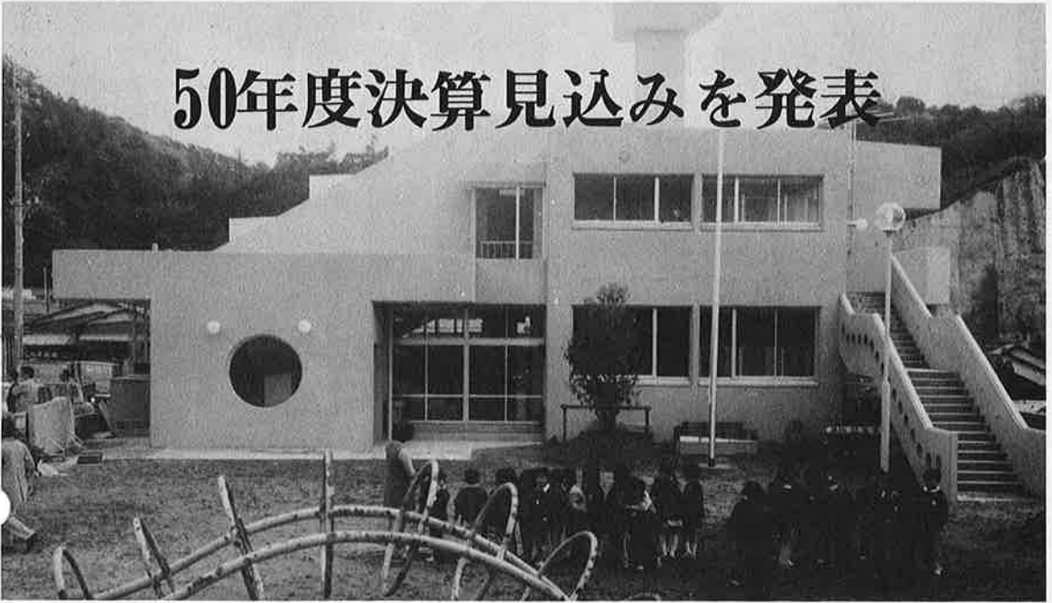
縮少ぎみの建設事業のなかで漁港整備や保育所(写真)など住民に直結した重点事業が行われました
