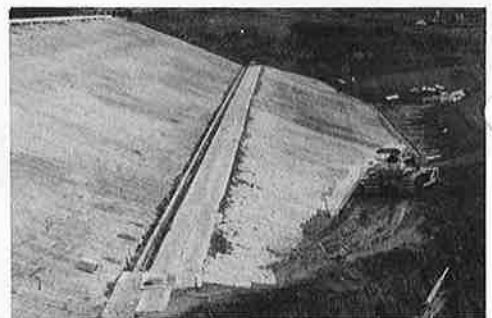
ダム堤体の芝張りも終わりガードレールも取り付けられた
