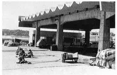
完成した荷さばき所
