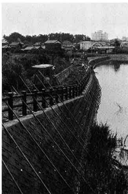
▲着工した清水川遊歩道
