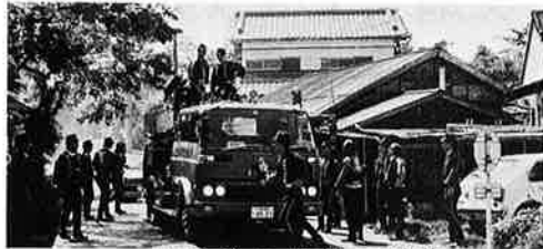
▲火災発生現場に到着
