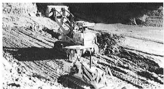
▲上布施土地改良ため池改修(小幡・鎌田堰)
