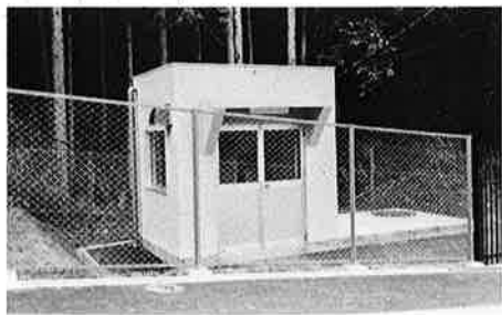
▲安定給水を目的に流量調整操作弁室建設
