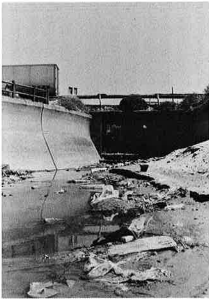
▲ 62、63年度の2か年事業で生活排水処理施設が建設される堺川
