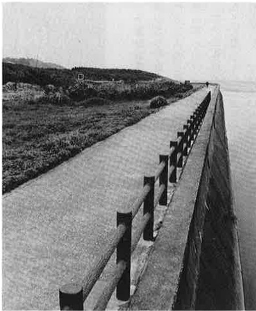
▲ 今年度着工する浦中地先の海岸道路と遊歩道
