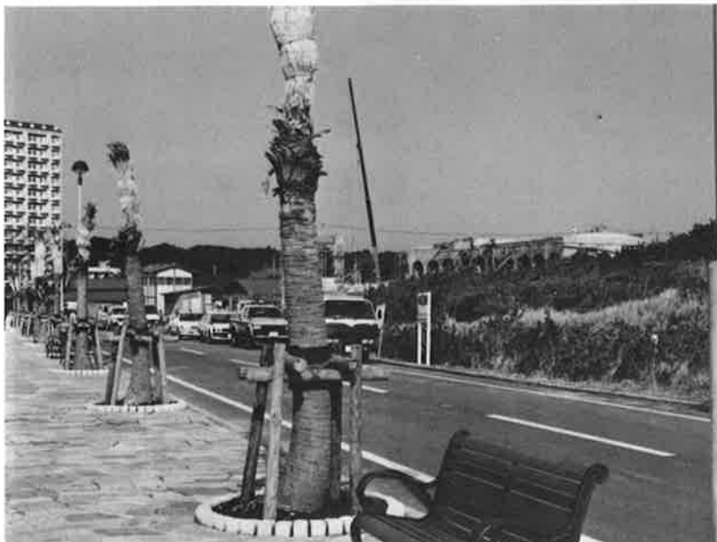
機能性に加え、誇りと愛着の持てる施設づくりを 完成間近な海岸道路と月の沙漠記念館（写真右奥）
