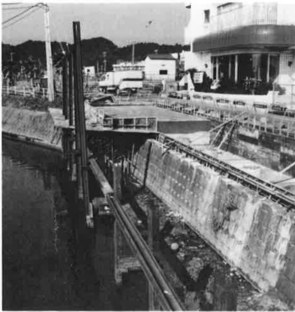
河川に張り出す工法で歩道を確保 清水川沿いの歩道新設工事
