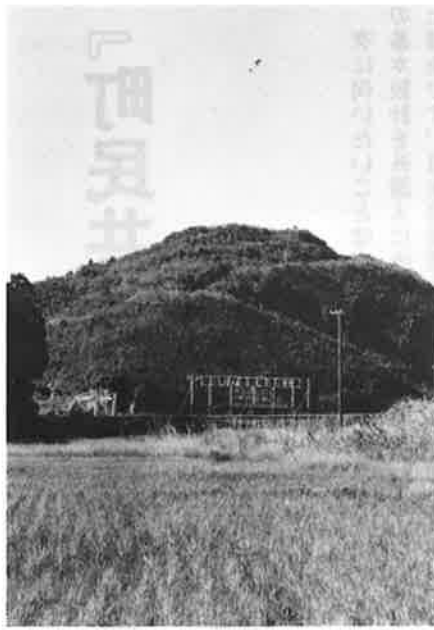
スタートした庁舎用地の造成工事 (須賀・中黄金地先)
