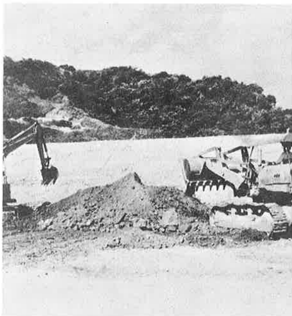
造成の進むプールと体育館の建設予定地
