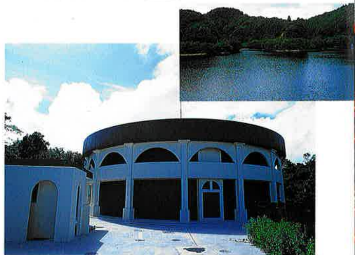
水道拡張事業による第二配水池を建設
