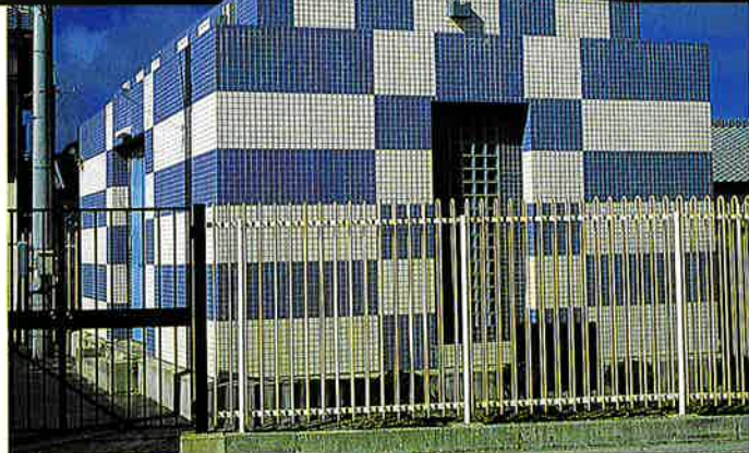
堺川生活排水浄化施設
