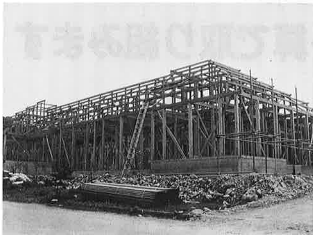
建設進む地域福祉センター
