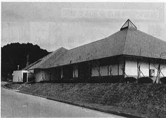
完成した地域福祉センター
