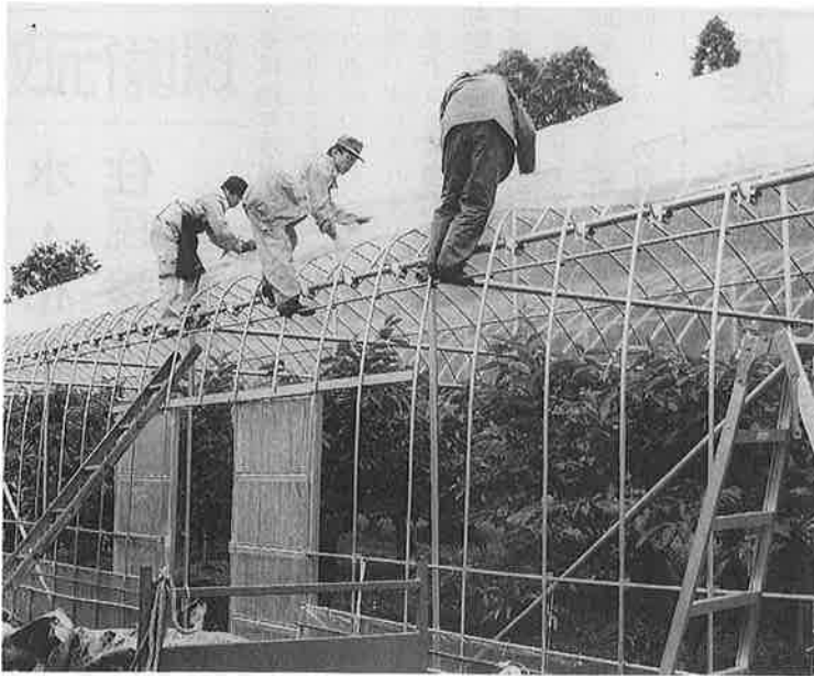
生産効率を高めるために様々な試みが (柿、雨よけハウス設置作業)
