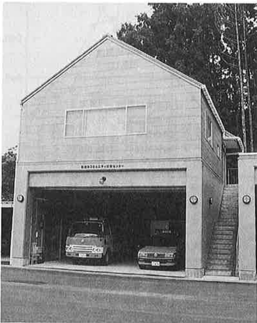
今年3月に完成した消防コミュニティーセンター
