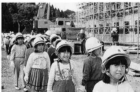
子供たちも庁舎建設現場を見学しました。
