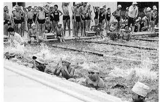
布施小学校に待望のプールが完成。
