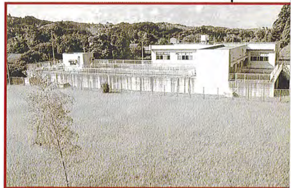
昭和53年 上水道の給水が始まる
