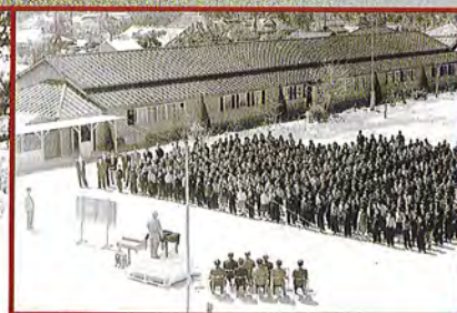
昭和33年 御宿中学校の増築工事が完成
