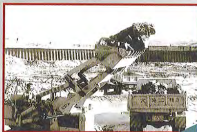
昭和39年 建設が進められる御宿漁港
