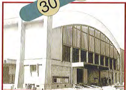
昭和40年 御宿中学校の体育館が完成
