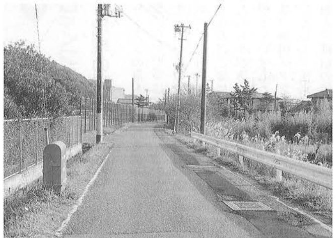
町道0202号線の早期着工に向け、基礎調査を行っています
