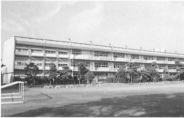
御宿小学校では、校舎の外壁改修工事を行い、教育施設の充実に努めました
