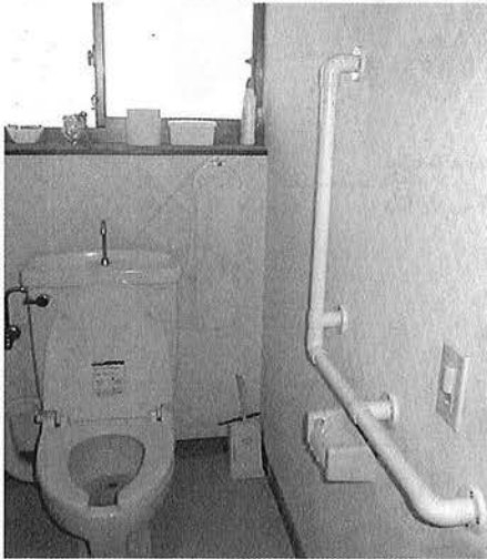
トイレに取り付けた手すり
