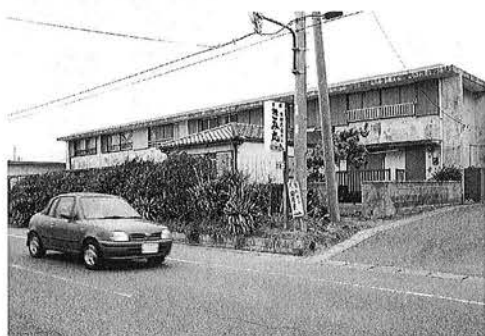
3年間にわたり順次、外壁を修理していく予定の岩和田団地
