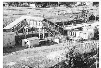
跨線橋の屋根が設置されたことで、より安全にホームまで渡れるようになりました
