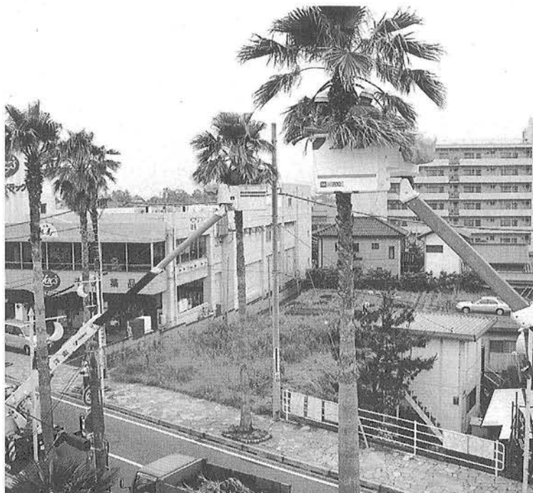
高所作業車を使って、ヤシの葉を伐採しました
