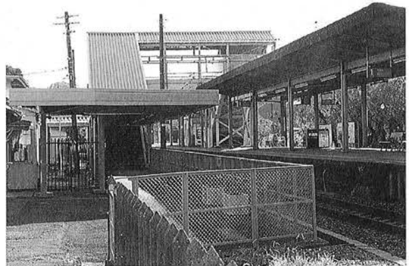
住民要望から7年。ようやく完成した駅跨線橋の屋根
