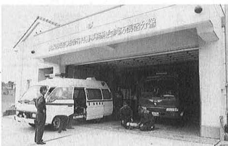
御宿分署には、消防車と救急車、連絡車が配備されています
