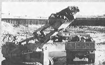
S39 御宿漁港竣工
