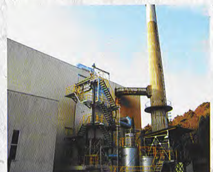
H14 清掃センター改修工事が完成
