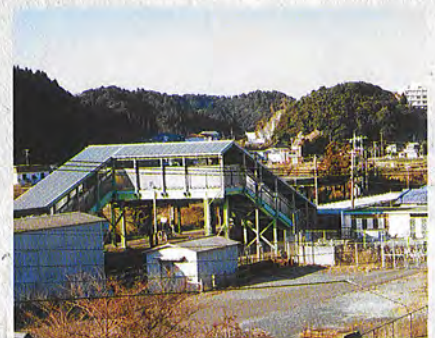
H14 御宿駅跨線橋上屋工事完成
