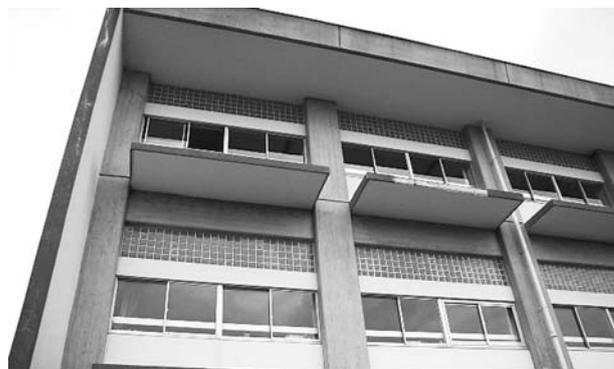
▲校舎は校庭側窓15箇所に鉄骨造の斜材を設置し、耐震補強を図ります
