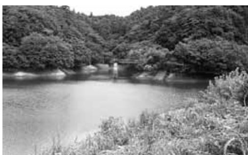
▲水位が下がり壁面が現れた御宿ダムの様子
