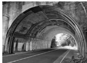
▲小納戸トンネル補修工事
