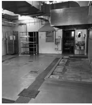
▲御宿小学校配膳室改修工事
