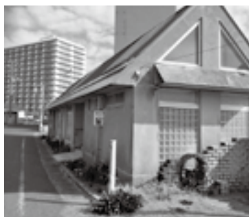
▲浜公衆トイレ
