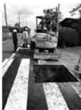
▶漏水工事（上布地先県道）
