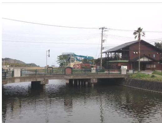
補修を予定している地曳橋
