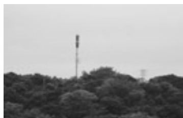
▲現在使用されているテレビ共聴施設
