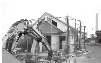
▲メキシコ記念公園トイレ改修
