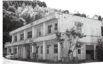
▲御宿町浄水場
