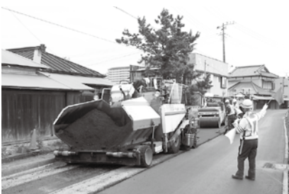
▲臨時交付金事業による道路舗装工事
