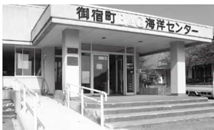
▲臨時交付金事業によるスロープ設置（海洋センター）
