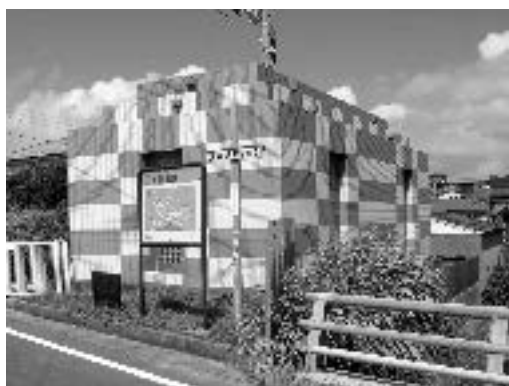
▲堺川生活廃水処理施設
